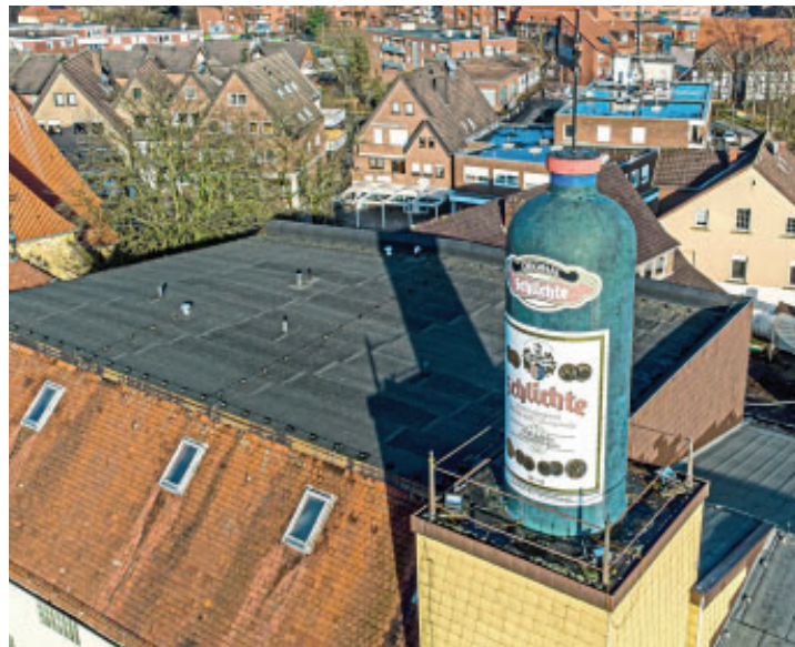
Die Kruke, sechs Tonnen Stahlbeton, der grünen Schlichte-Glasflasche der 1970er-Jahre nachempfunden, kam wohl 1946/47 aufs Dach des heutigen Schlichte-Carrees.
