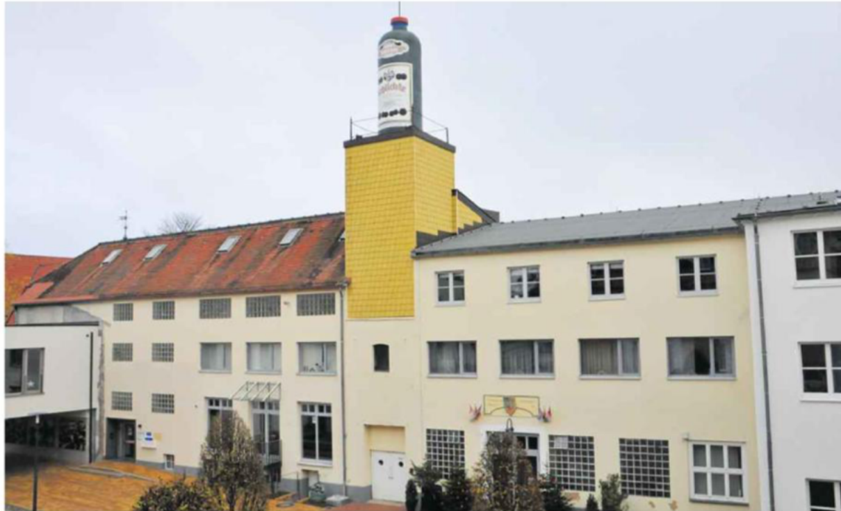
Blick in den Innenhof des Schlichte-Carrees. Die Fassade einschließlich des Turms mit der Kruke wird im kommenden Jahr saniert.
