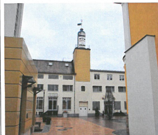
Ein Durchbruch vom Schlichte-Carree in einen zweiten Hof hinter dem Museum ist baulich so gut wie unmöglich. FOTO: FRANK JASPER
